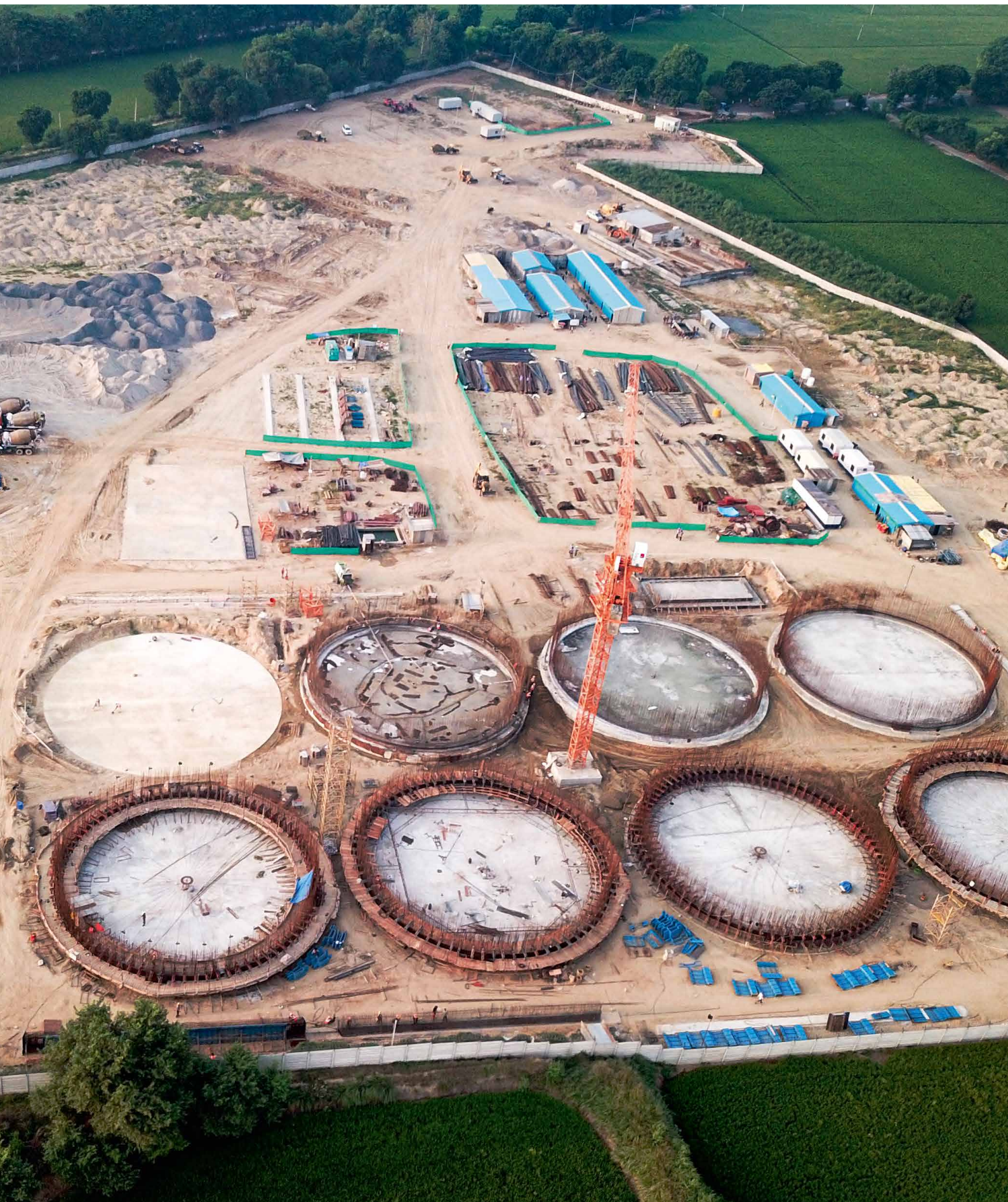
Im Bau: Stroh-Biomethan-Anlage am VERBIO Standort in Indien
