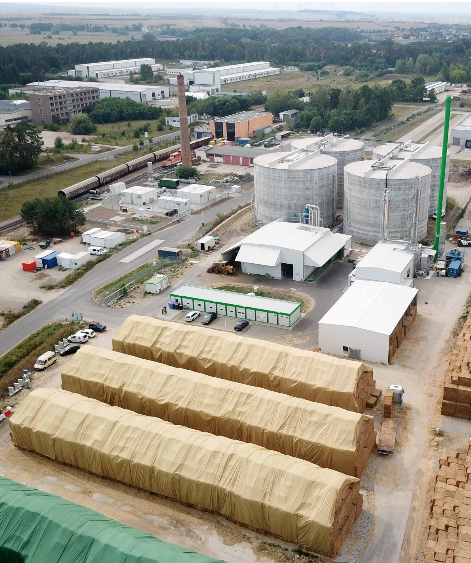
Die neue VERBIO Bioraffinerie in Pinnow (Brandenburg)
