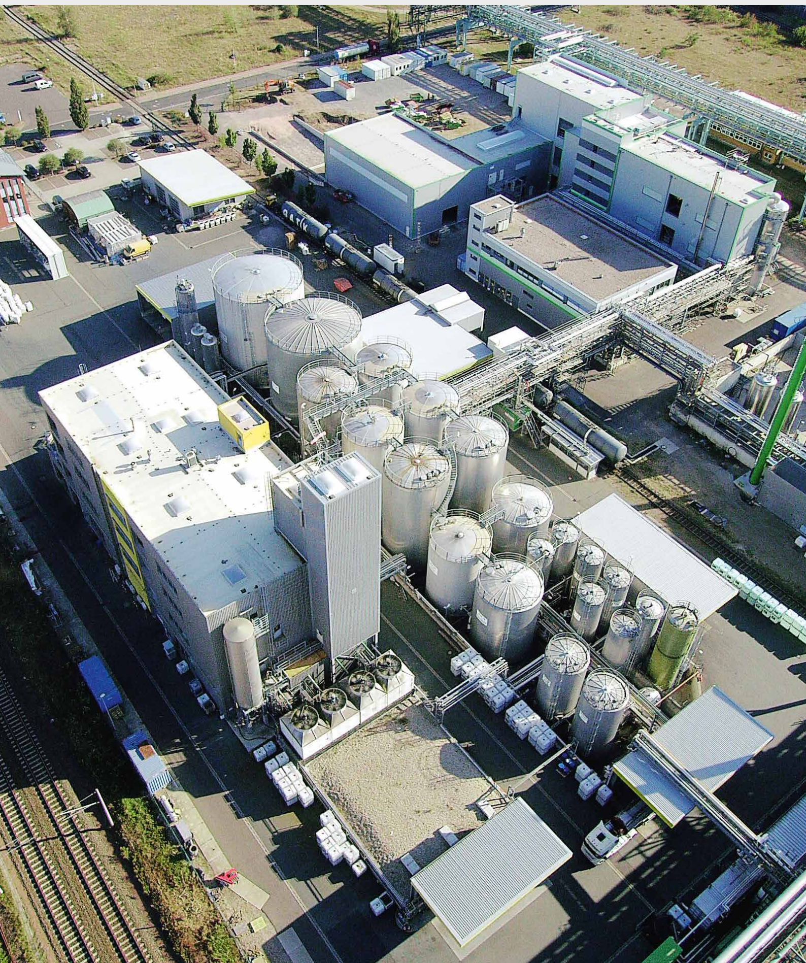
VERBIO Standort in Bitterfeld nach Ausbau der Sterolanlage (Sachsen-Anhalt)
