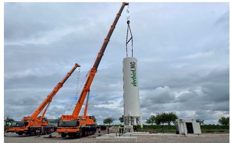
First VERBIO LNG filling station in Zörbig
